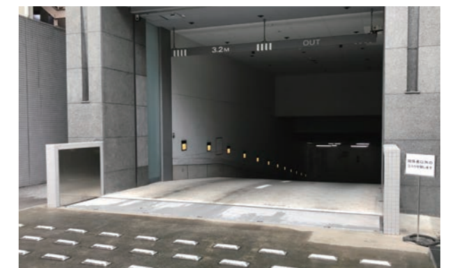
オフィスビル 地下駐車場入口(東京都千代田区)
