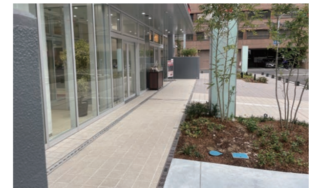
ホテル エントランス(大阪府大阪市)
