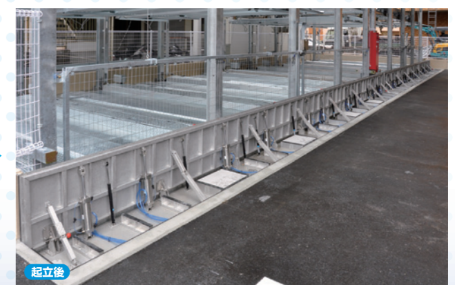
(広島市 南区)広島信用金庫 宇品支店 正面玄関、通入口、屋内に計3基 【正面玄関:有効幅3.35m/有効高0.5m(タイル貼り仕上げ) / 通入口:有効幅1.5m/有効高0.5m(ポリカプレート仕上げ) / 屋内設置:有効幅2.635m/有効高0.5m(タイルカーペット仕上げ)】
