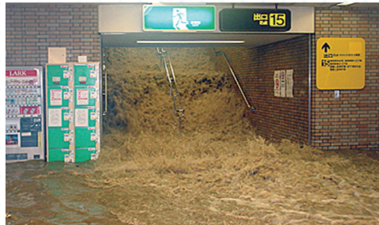
平成15年7月 福岡市豪雨災害 福岡市地下鉄博多駅筑紫口(提供:国土交通省 九州地方整備局より)
